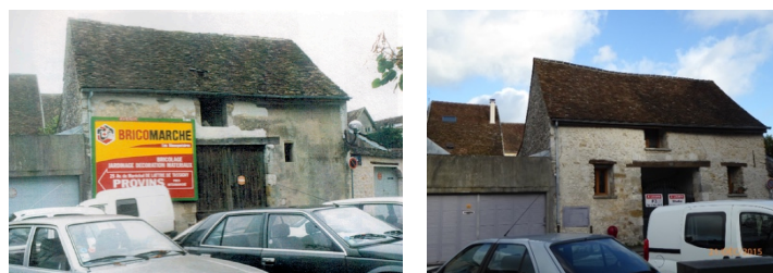
Dispositif mural existant en 1996, puis supprimé
