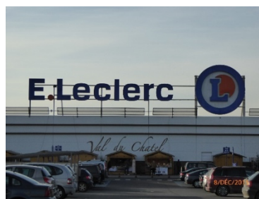
Enseigne en toiture
