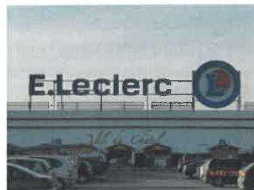
Enseigne en toiture
