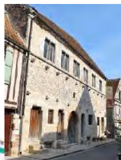
Grange aux Dîmes (Cl. M.H. : 16 avril 1847)
