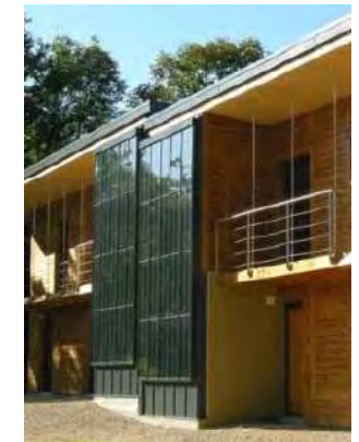
Energie renouvelable: Panneaux solaires intégrés à la façade
