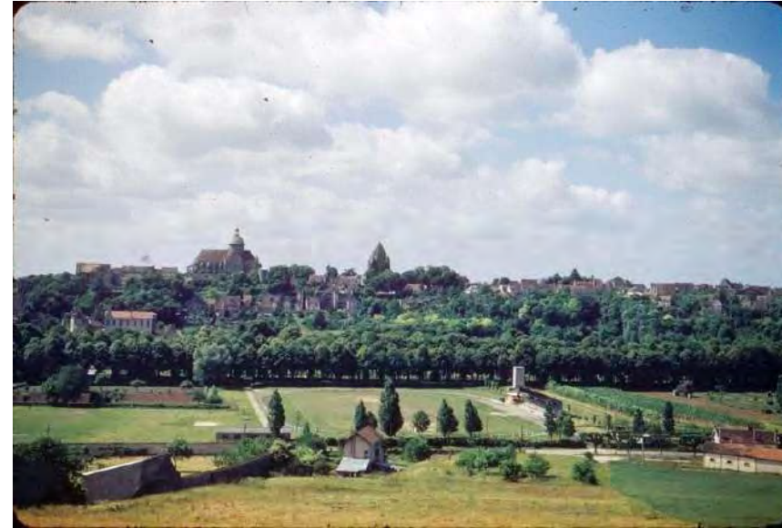
Vue des abords pentus de L'Hôpital / Cordelières
