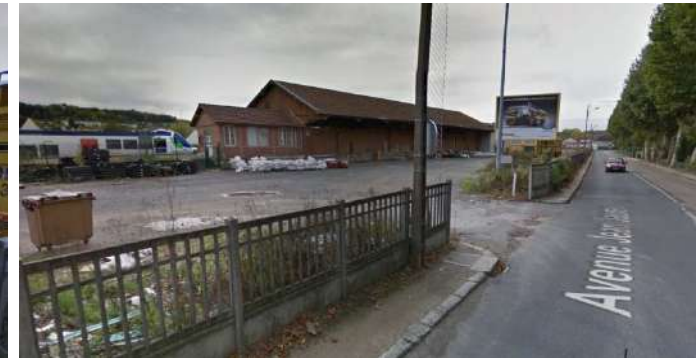
② Avenue Jean Jaurès vers l'Ouest
