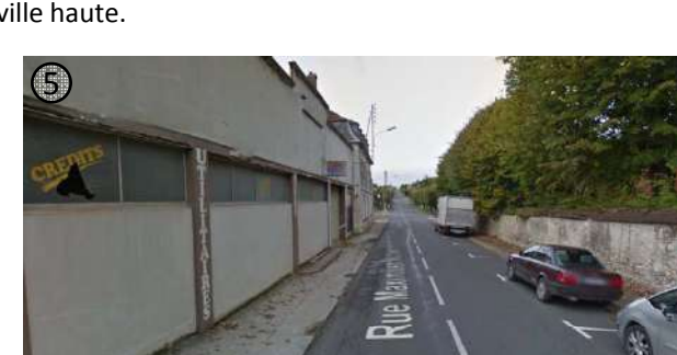
Ancien garage situé rue Maximilien Michelin.
