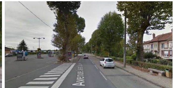
④ Avenue Jean Jaurès vers l'Ouest à proximité de la traversée vers le centre ville
