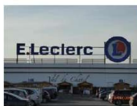
Enseigne en toiture
