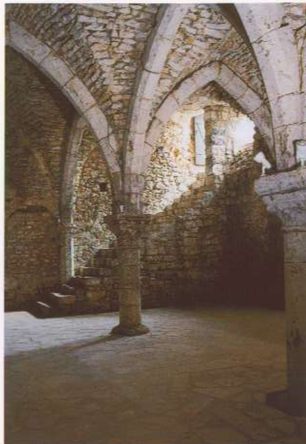
Caveau au 46, rue de Jouy.
