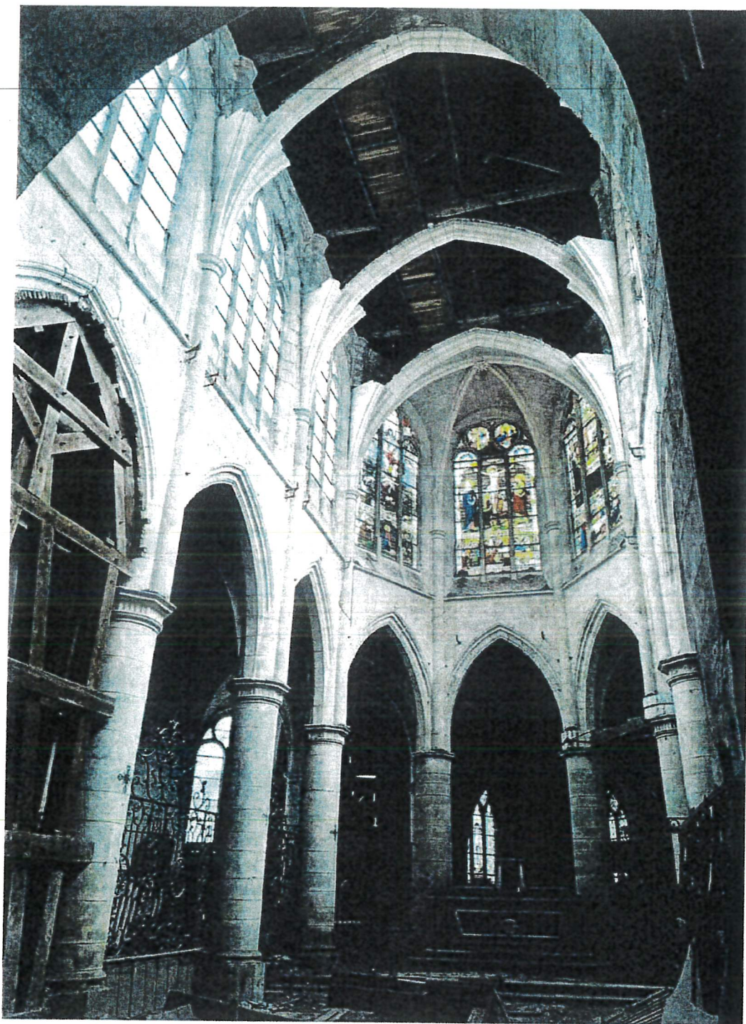
Vue générale intérieure du vaisseau central du chevet. La restauration des parties hautes est déjà engagée. Le présent programme d'opération concerne les parties basses : piliers, sols, maître autel, grilles, stalles, etc.
