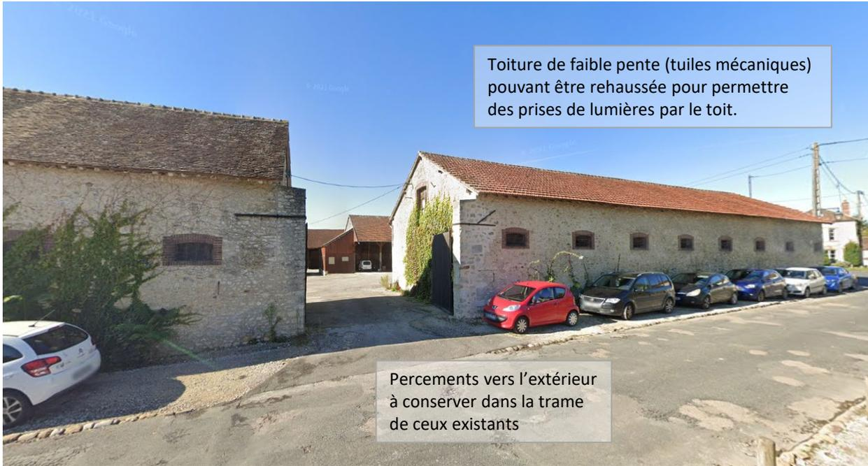
Toiture de faible pente (tuiles mécaniques) pouvant être rehaussée pour permettre des prises de lumières par le toit.
